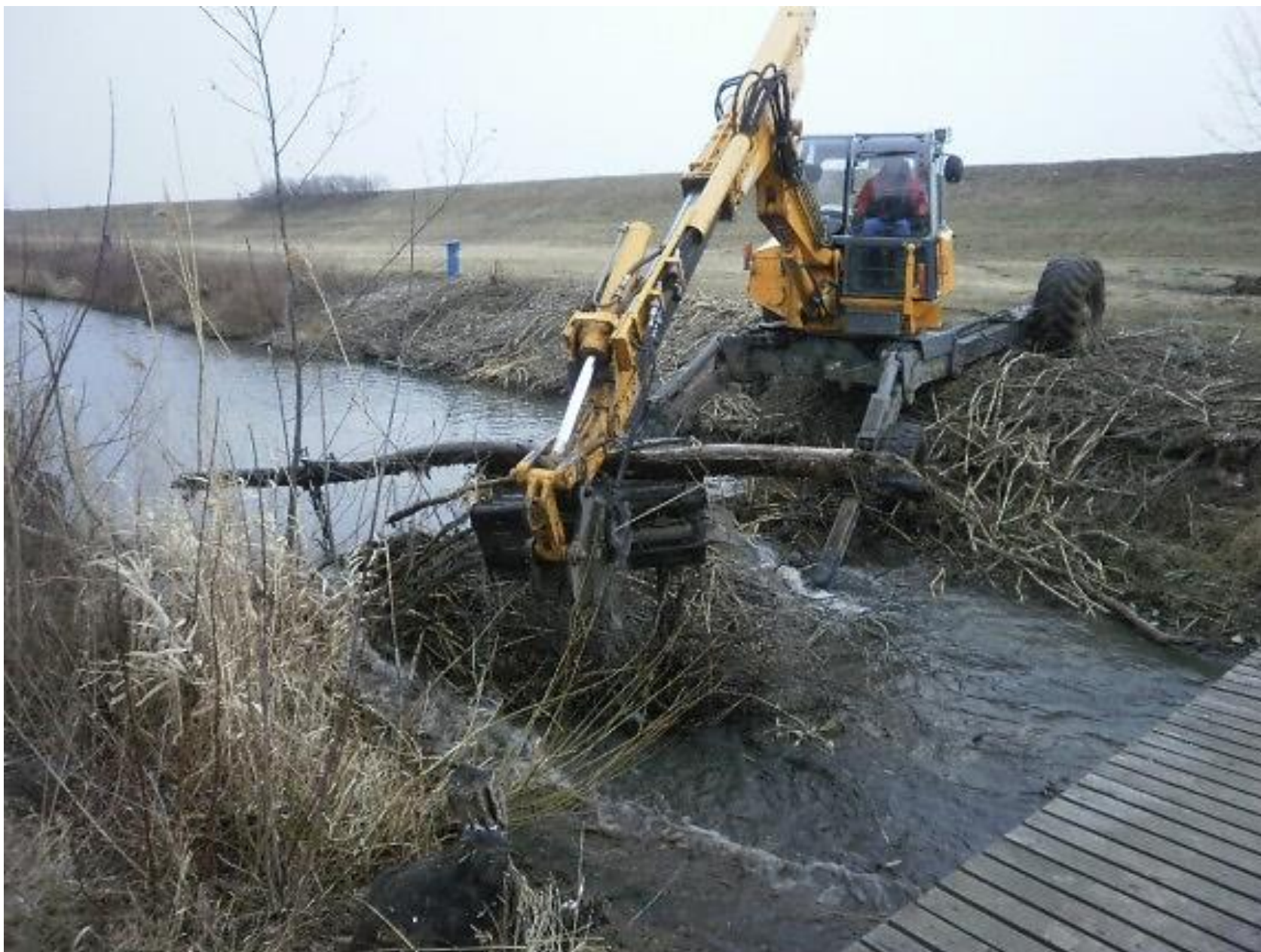
Odstraňování bobří hráze v lokalitě vodního díla Nové Mlýny – provádí Povodí Moravy s. p. na základě povolení krajského úřadu Jihomoravského kraje.
