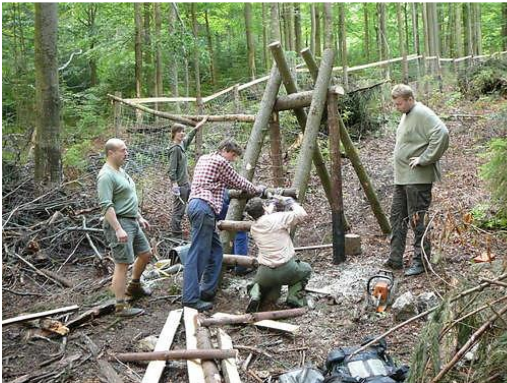
Stavba přejezu oplocenky
