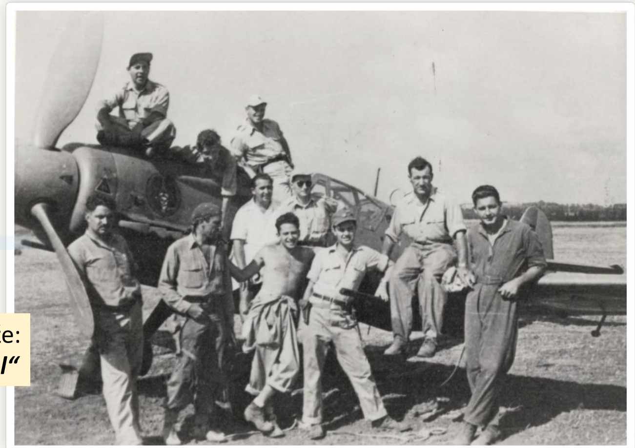
československé zbraňové dodávky Izraeli sestávaly hlavně ze zanechaných německých zbraní. Na snímku izraelští piloti u letounu Avia S-199. Jednalo se vlastně o drak letounu Messerschmitt Bf-109 s motorem určeným původně pro německé bombardéry. Izraelští piloti říkali těmto hybridním mesršmitkám prostě "Mesr" nebo hebrejsky "Sakin" (nůž).
