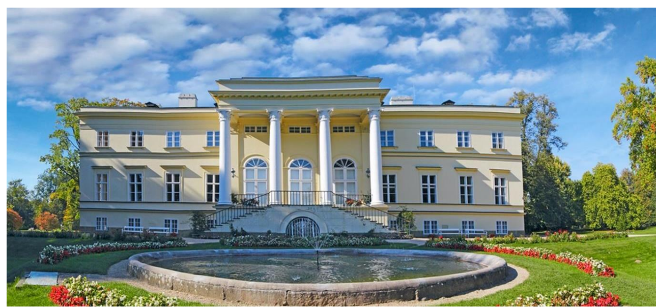
Nový zámek v Kostelci nad Orlicí - v empírovém stylu - 1829-33.
